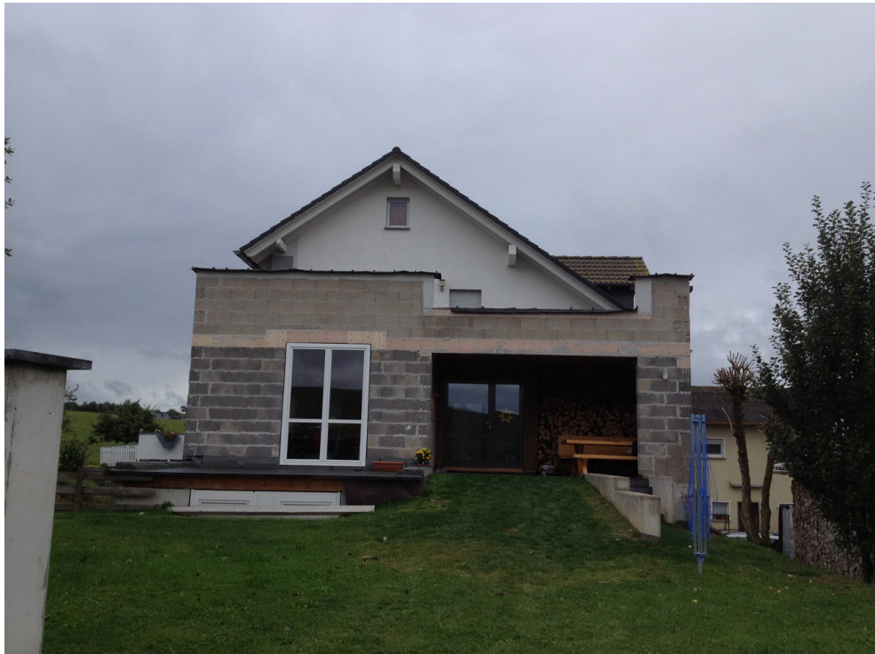
Abb.: Anbau aus östlicher Richtung (Foto vom 25.09.2012)
