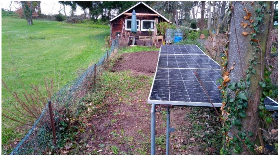
Balkonkraftwerk als mobile Agro-PV-Anlage
